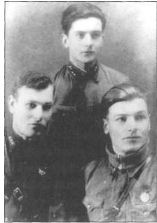
Слева направо: зам. ком. АЭ М. Пивоваров, инженер по АВ С. Едигаров, зам. нач. штаба полка Бровко
